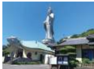
亀の形をした霊廟の上に建つ万国霊廟長崎観音は高さ18メートル(地上34メートル)。
